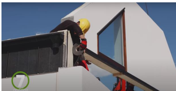
Montaż ścianek poddasza ze stolarką okienną
