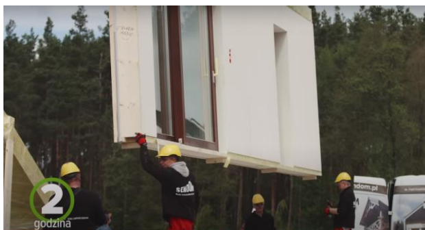
Montaż ścian parteru wyposażonych w stolarkę okienną
