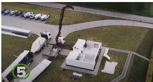
Montaż stropu, schodów i instalacji rekuperacyjnej
