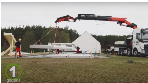
Montaż płyty fundamentowej wraz z instalacjami ogrzewania
