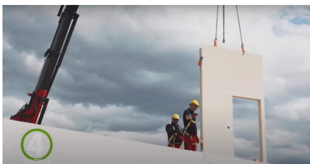
Montaż ścian działowych i instalacji elektrycznych i wod-kan
