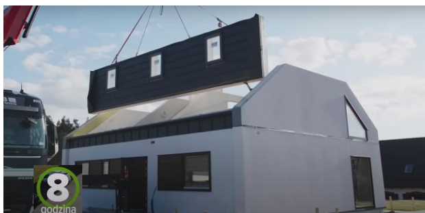
Montaż gotowych paneli dachowych z dachówką
