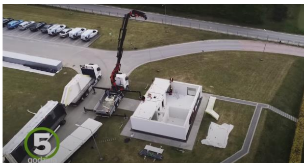
Montaż stropu, schodów i instalacji rekuperacyjnej
