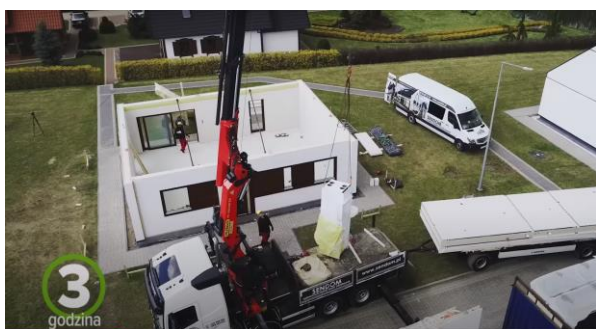
Montaż ścian szczytowych z szafą techniczną
